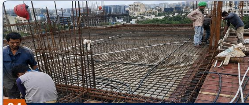
04 SLAB CONDUIT INSTALLATION
