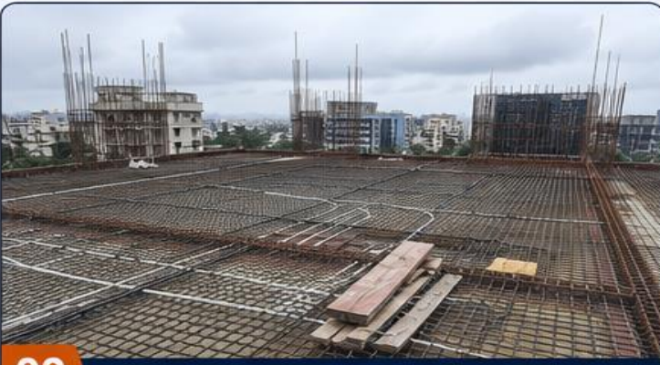
03 SLAB CONDUIT INSTALLATION
