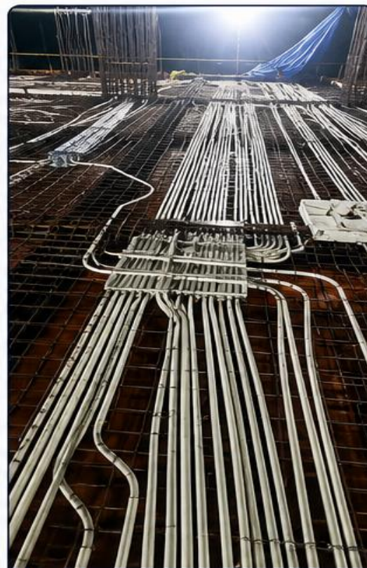
CONDUIT LAYOUT WORK
