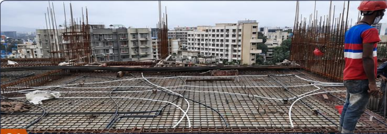
01 SLAB CONDUIT INSTALLATION
