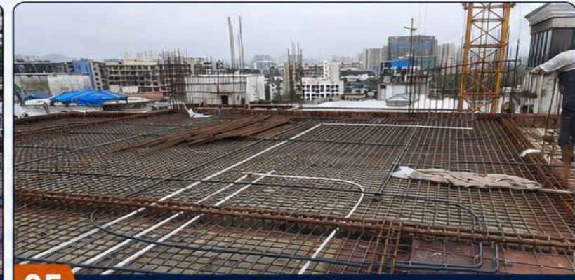
05 SLAB CONDUIT INSTALLATION
