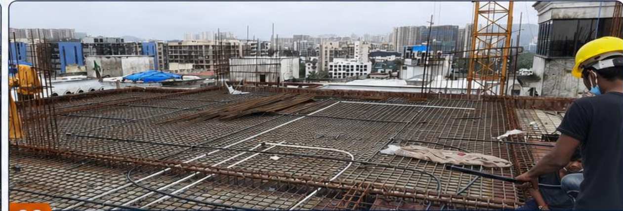
02 SLAB CONDUIT INSTALLATION
